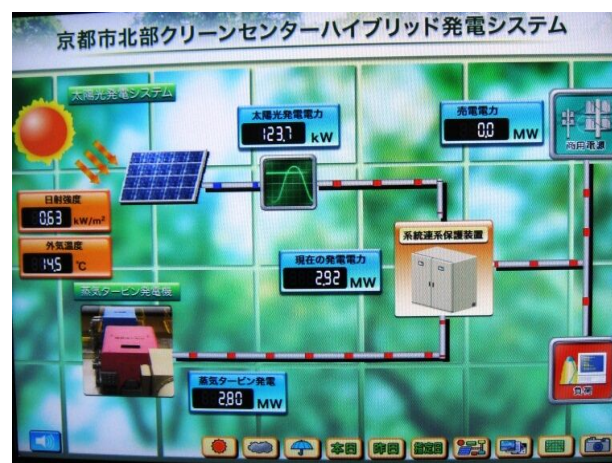
発電システム揭示板
