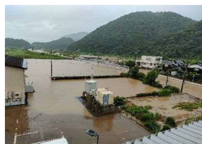
写真21: 塩見川水害状況
